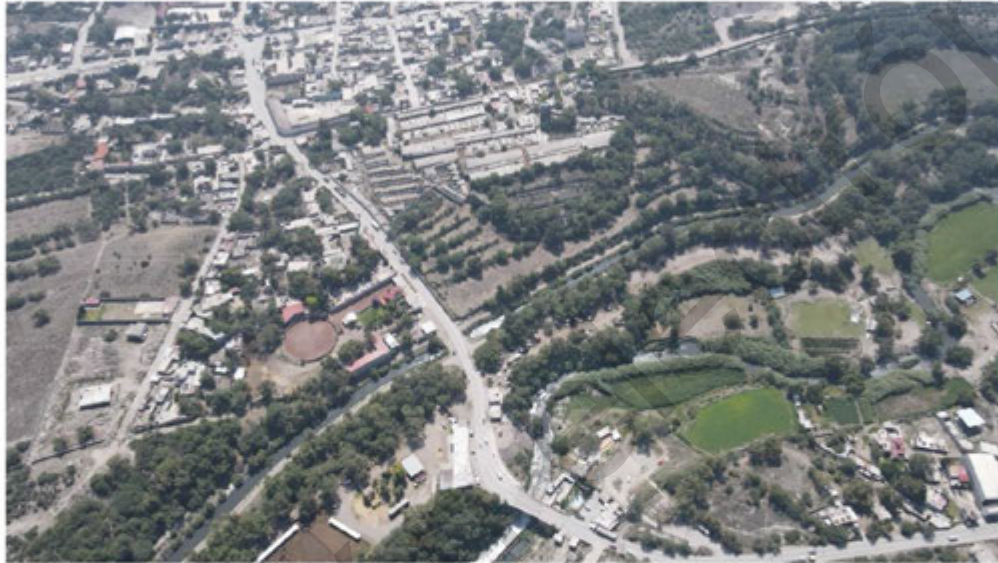
Canales Aguas Residuales Localidad El Vito.
