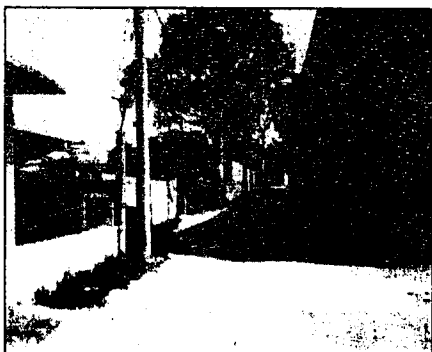
Aspecto de calle principal con servicio de alumbrado público, El Crucero
